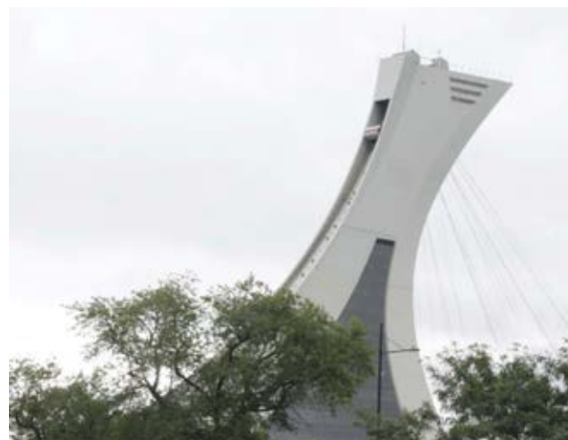
Com 45 graus de inclinação foi construído para aguentar o teto do complexo olímpico
